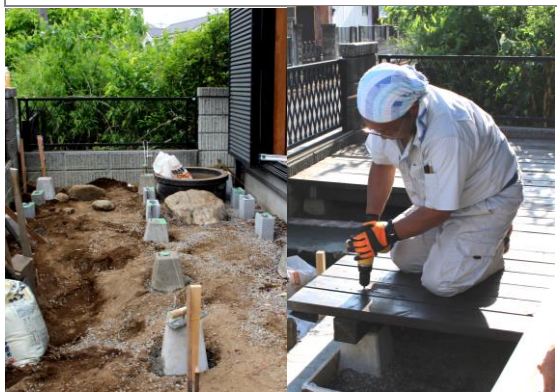
基礎工事から、コンクリートの打ち付けまですべて渡辺マネジャー監修のもと行いました。榎本職員のご家族や大地の職員が土・日曜日に手伝ってくれました。皆さん、ありがとうございました。
